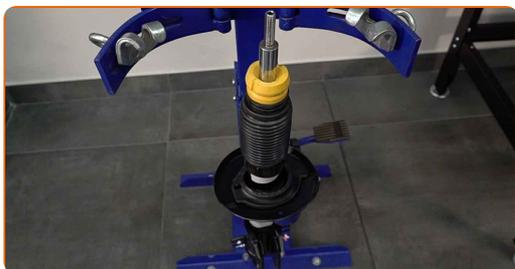
**31** Installieren Sie die Feder am Stoßdämpfer.
