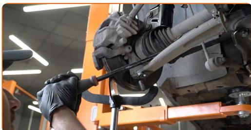
**15** Entfernen Sie den Träger unter dem Achsschenkel.
