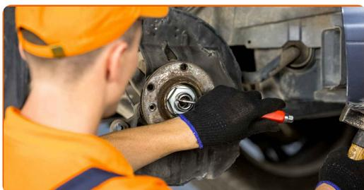
**21** Reinigen Sie die Befestigungen des Radnabenlagers. Benutzen Sie eine Drahtbürste. Benutzen Sie WD-40-Spray.
