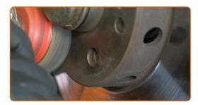
Behandeln Sie die Oberfläche, an der die Bremsscheibe die Felge berührt. Verwenden Sie Keramikfett.
