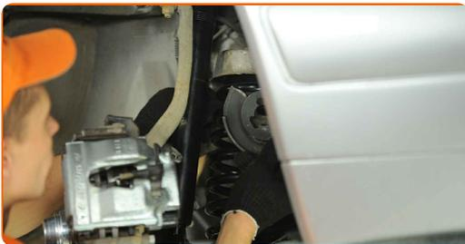
**24** Entfernen Sie den Spiralfederspanner.
