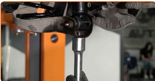
**26** Ziehen Sie den unteren Befestiger des Stoßdämpfers an. Verwenden Sie Ring-Gabelschlüssel Nr. 13. Verwenden Sie Stecknuss Nr. 15. Verwenden Sie einen Drehmomentschlüssel. Ziehen Sie ihn mit 57 Nm Drehmoment fest.
