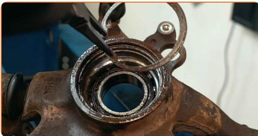
**34** Reinigen Sie den Einbauort für die Nabenlagerung. Benutzen Sie eine Drahtbürste. Benutzen Sie WD-40-Spray.
